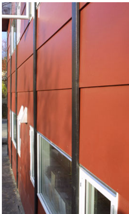
Træfacaden på Helsingør Lille Skole.
