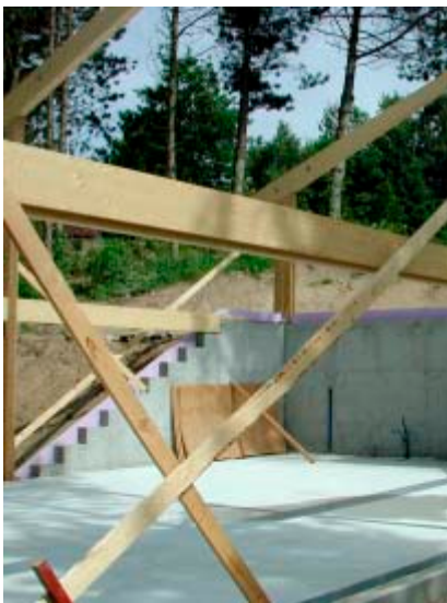
Husets stabiliserede limtræs-rammer.
