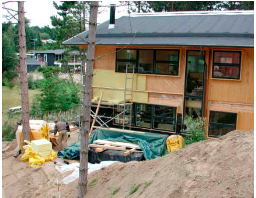
Huset isoleres med 200 mm mineraluldsisolering i to lag.
